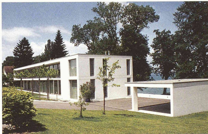
Die Einfamilienhäuser Marx in Mammern (oben) und Hirt in Uttwil (unten), beide Baujahr 1999/2000. Wärmedämmung Haus Marx: Foamglas T4/120 mm, 400 m 2 Flachdach begrünt; Wärmedämmung Haus Hirt: Foamglas T4/160 mm, 200 m 2 Flachdach bekiest, Foamglas T4/120 mm, 100 m 2 Innendämmung Decke und Wand; Systemberatung und Ausführungskontrolle: Foamglas-Zweigbüro Nordostschweiz, Kreuzlingen
