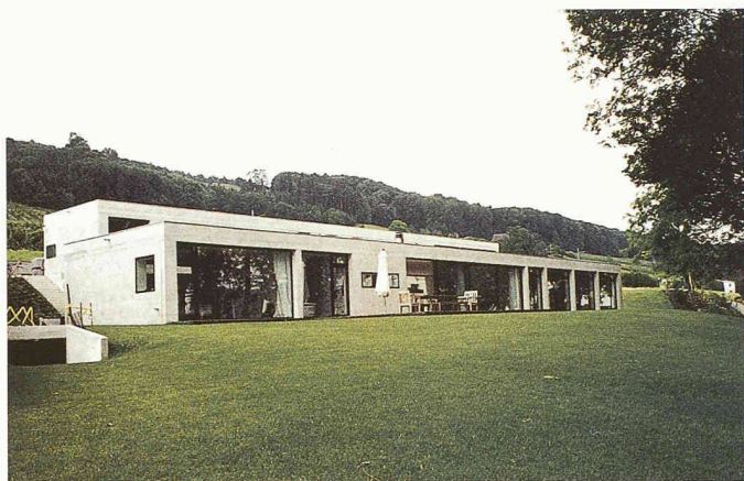
Die Einfamilienhäuser Marx in Mammern (oben) und Hirt in Uttwil (unten), beide Baujahr 1999/2000. Wärmedämmung Haus Marx: Foamglas T4/120 mm, 400 m 2 Flachdach begrünt; Wärmedämmung Haus Hirt: Foamglas T4/160 mm, 200 m 2 Flachdach bekiest, Foamglas T4/120 mm, 100 m 2 Innendämmung Decke und Wand; Systemberatung und Ausführungskontrolle: Foamglas-Zweibüro Nordostschweiz, Kreuzlingen
