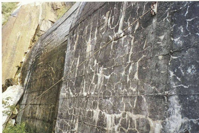
Galerie Kt. Bern: typisches AAR-Rissmuster mit Kalkablagerungen
