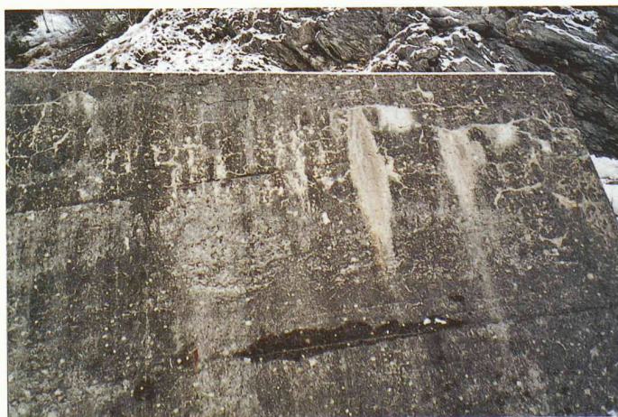
Stützmauer Kt. Graubünden: AAR-Risse im oberen Teil der Mauer mit deutlichen Kalkausblühungen
