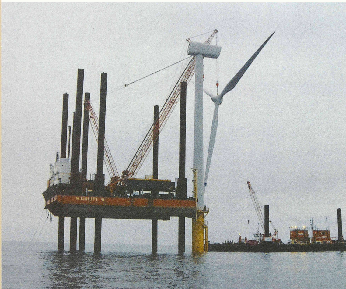
Heben des Rotors
