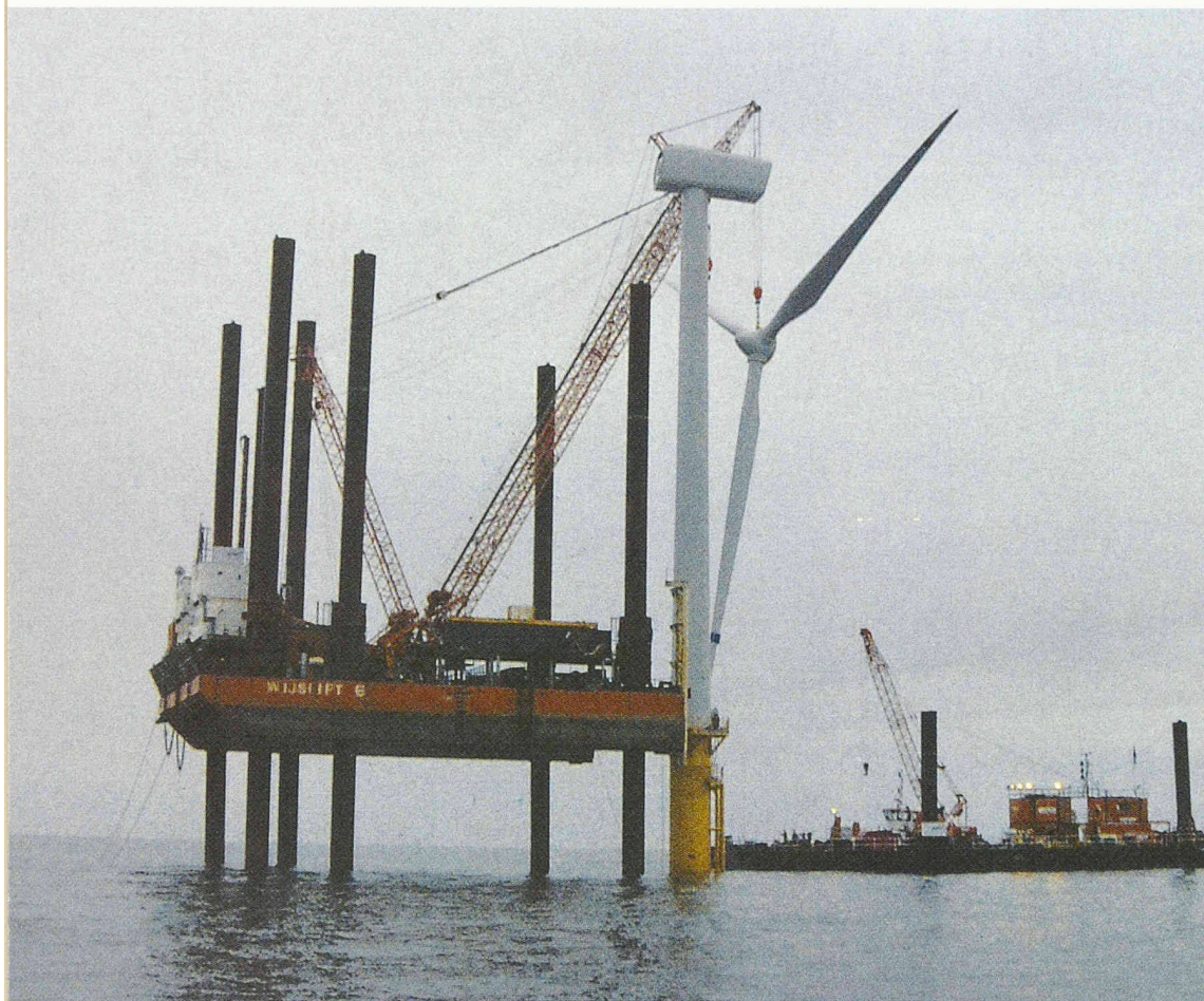
Heben des Rotors
