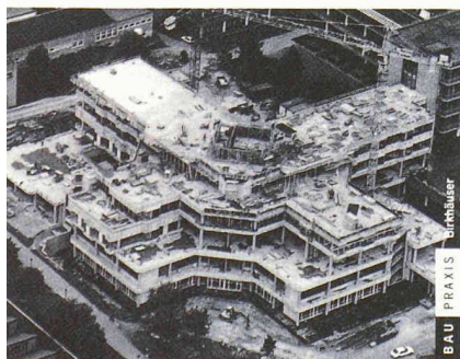
Peter Eyerer Hans-Wolf Reinhardt Ökologische Bilanzierung von Baustoffen und Gebäuden Wege zu einer ganzheitlichen Bilanzierung
