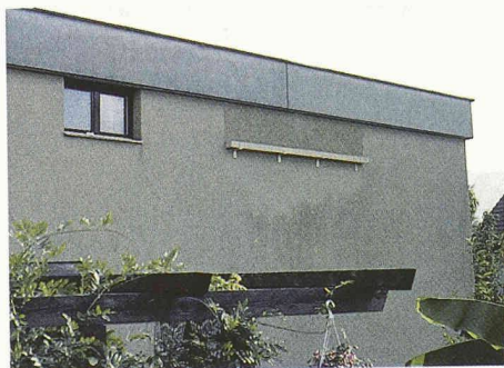
Oben links: Erhaltung der Durchschlupföffnung im Zuge der Dachsanierung Oben rechts: Bauwerke können auch zu Fallen werden: im Innenraum dieses Brückenpfeilers verirrt sich Fledermäuse. Dieses Problem wurde mit einem Fledermauskasten im Innern behoben Unten: Eine neu eingesetzte Etegranplatte mit einer Auffangvorrichtung erlaubt eine leichte Reinigung von Kot und Urin. Die schwarzen Verfärbungen um die Platte sind allerdings auf die Luftverschmutzung zurückzuführen (Bilder: A. Beck)
