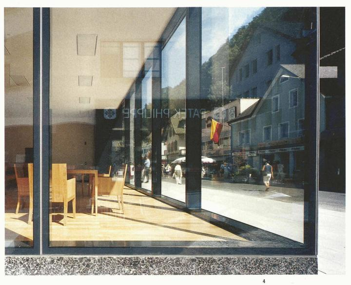
Offene Ecke: keine Stütze; silikonverklebte Glaspakete
