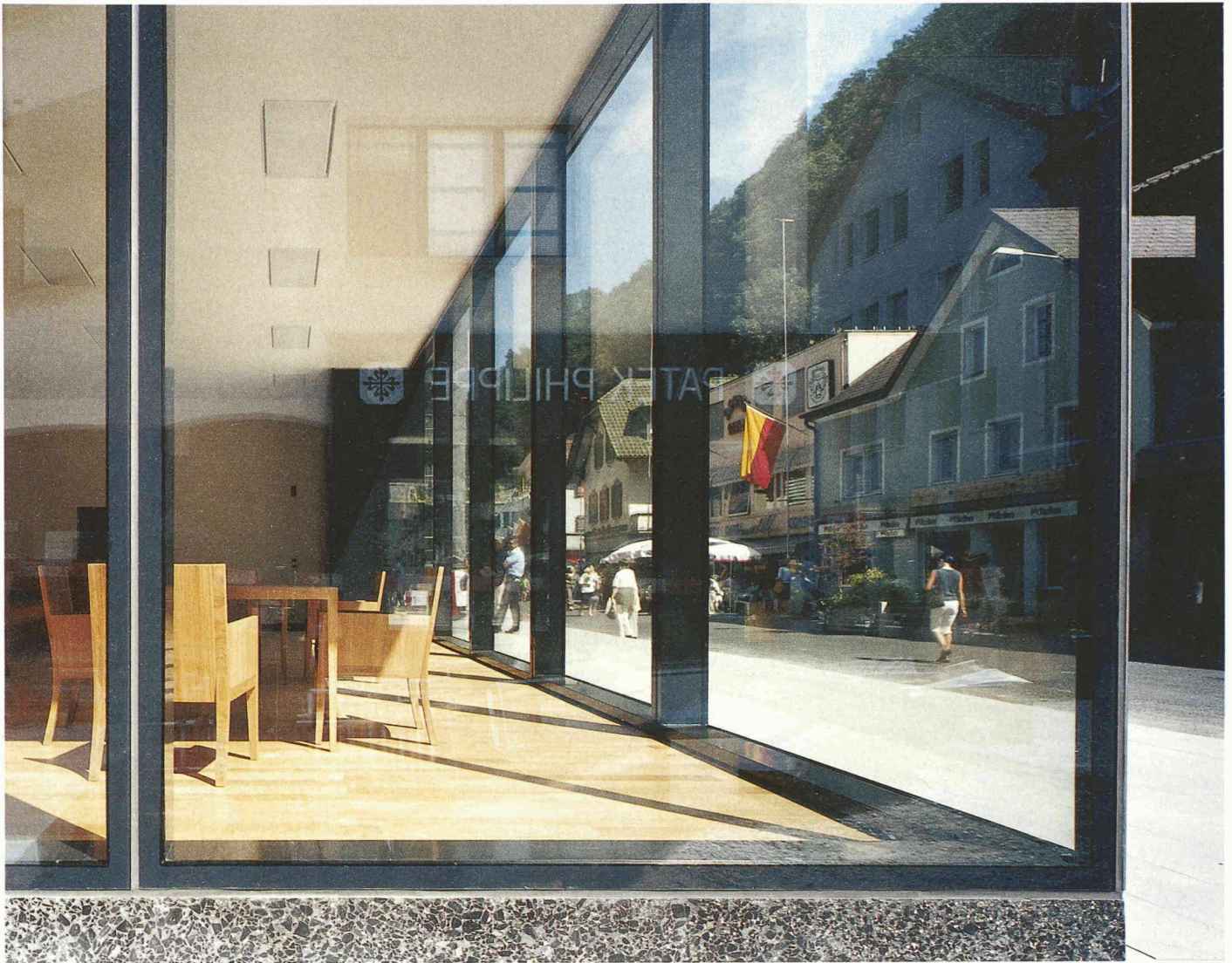
Offene Ecke: keine Stütze; silikonverklebte Glaspakete
