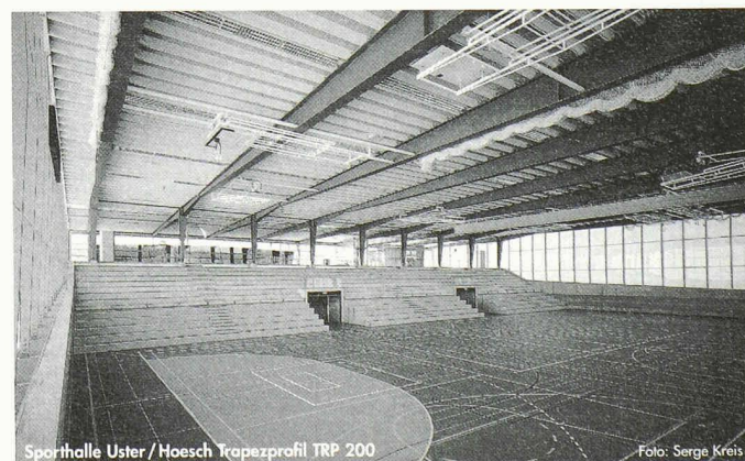
Sporthalle Uster / Hoesch Trapezprofil TRP 200
