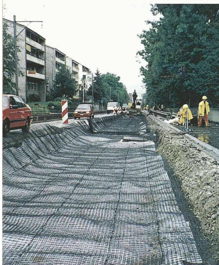
Ein fünfzigiges Geogitter über einem Geovlies ersetzt Tonnen von Kies beim Fahrbahnaufbau der Bernstrasse in Zollikofen BE
