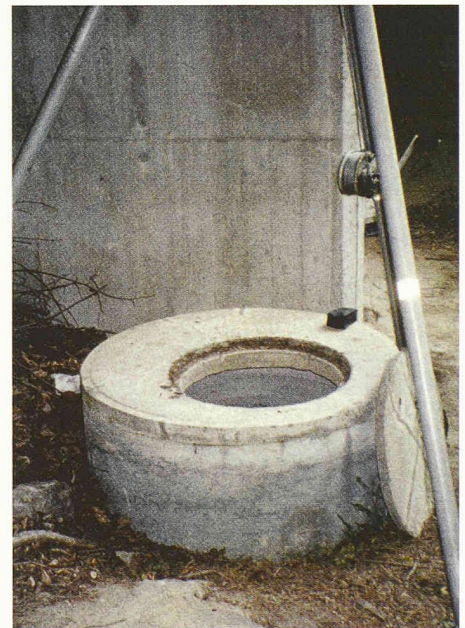
Die Pfeilerschächte der Brücken wurden visuell inspiziert. Die Deckel werden durch abschliessbare ersetzt
