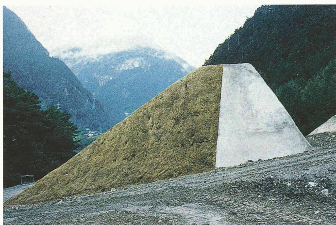
Seitenansicht Bremsverbauten
