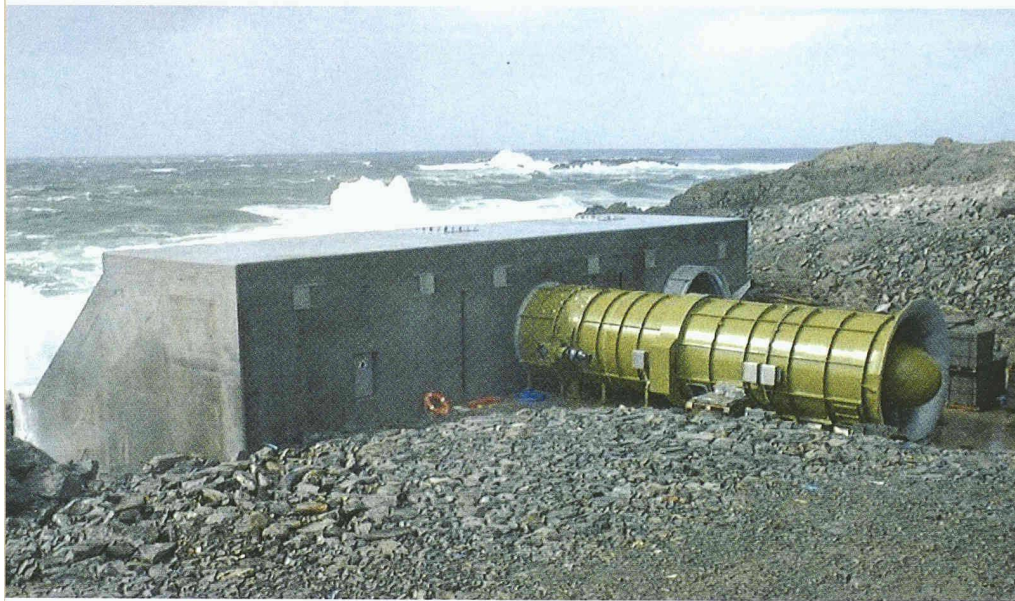
Der Turbinenausgang und die Rückwand des Kollektors (links). Der Limpet passt sich in die Küstenlandschaft ein (oben). (Bilder: Wavegen)
