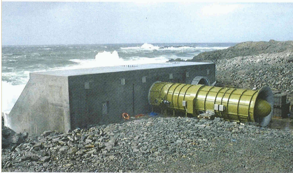
Der Turbinenausgang und die Rückwand des Kollektors (links). Der Limpet passt sich in die Küstenlandschaft ein (oben). (Bilder: Wavegen)
