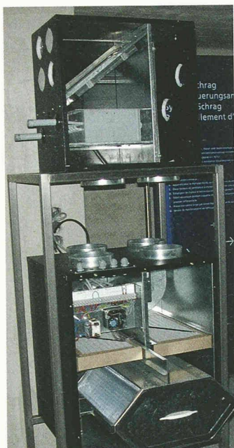
Die Lüfterneuerungsanlage «System Schrag» saugt Luft aus belasteten Räumen (Küche, Bad und WC), und führt angewärmte Frischluft in Schlaf-, Wohn- und Kinderzimmer
