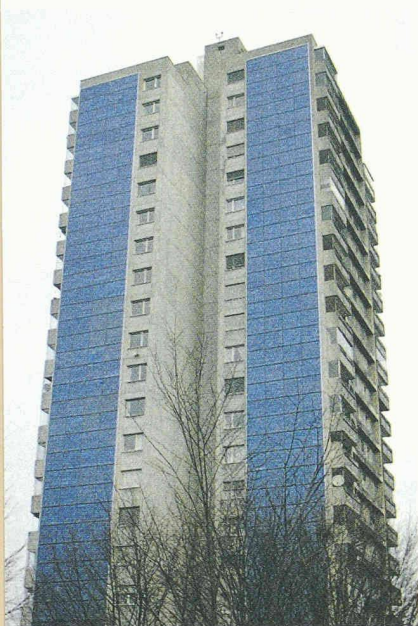
Fassaden-Solkraftwerk Bern-Wittgkofen mit seinen 328 Photovoltaik-elementen (links), Brandschutzleiste am unteren Rand (oben)
