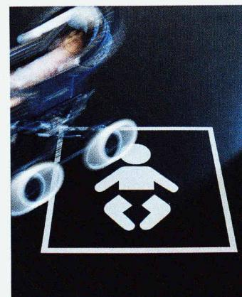
Aquajet heisst das computergesteuerte Verfahren, das dabei zur Anwendung kommt. Die Motive werden mittels EDV erfasst und anschliessend durch einen hochpräzisen Wasserstrahl aus dem Material ausgeschnitten. Werden die Intarsien fachgerecht verlegt, weist der Bodenbelag anschliessend eine uneingeschränkte strapazierfähigkeit auf. (Nachdiplomstudium für Fachleute in Signaletik siehe Seite 38, Anm. d. Red.)
