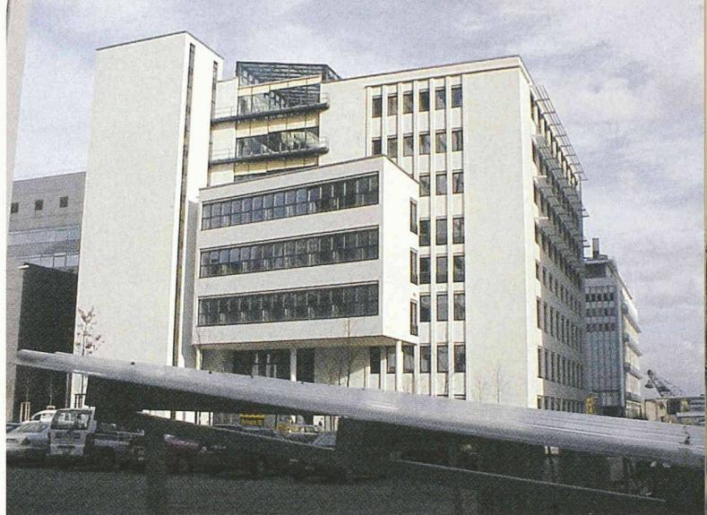
**Bei der Umnutzung von zwei Gebäuden entstand aus einem Zwischenraum ein Atrium. Dieses und die angrenzenden Büros werden natürlich belüftet. Dank anschliessender Betriebsoptimierung und permanenter Informationspolitik ist eine hohe Nutzerzufriedenheit erreicht worden. Zudem liegt der Wärmeverbrauch unter dem Minergie-Wert.**
