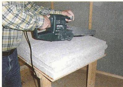
im Stapel bei nur geringer Staubentwicklung geschnitten werden. In der Vorfertigung und bei grossen Zuschnittmengen hat sich das Schneiden mit einer stationären Kreissäge bewährt. Eine Absaugvorrichtung für den Staub wird empfohlen.
