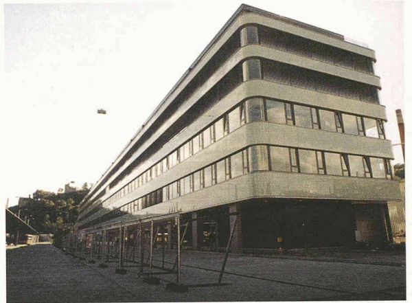
Das Wohn- und Geschäftsgelände «Langhaus» (Architekt Jan Hlavica, Metron AG) und der neue Busterminal am Bahnhof Baden (oben)
