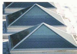
natürliche Belüftung der unteren Lokale benützen wie auch als Rauch- und Wärmeabzugsanlagen im Fall eines Feuers. Sie lassen sich durch zwei elektrische Zahnstanzenantriebe 24V in Tandemausführung in Betrieb setzen.
