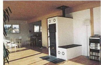
werden auf den Wärmebedarf des Hauses ausgelegt und entsprechend dem Hausgrundriss gestaltet, für einfache Fälle steht ein preisgünstiger Kleinspeicherofentyp zur Verfügung. Das System ist auch an bestehende Zentralheizungen anschliessbar, anstelle von Cheminées, Cheminéeöfen oder ersatzbedürftigen Heizkesseln.
