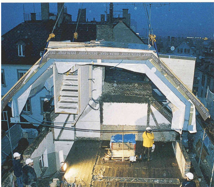
Altbausanierung in Richtung Passivhaus-Standard an der Magnusstrasse in Zürich: Neubau des Dachstocks (Bilder: Nina Mann)
