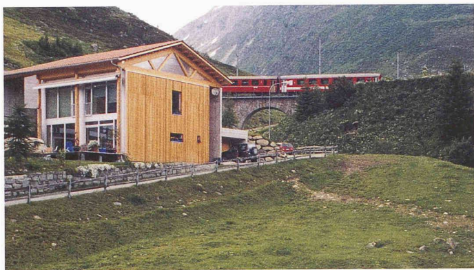
Das Passivhaus am Oberalppass mit nach Südwesten ausgerichteter Glasfassade (Bilder: Jörg Pfäffinger)
