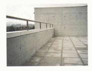
und kommt mit geringen Einbauhöhen aus. Das System kann im Hochbau überall dort angewendet werden, wo vertikale an horizontale Bauteile stossen und an dieser Stelle ein dichter, technisch sauberer Abschluss gefragt ist. Ein mindestens 18 cm breites, 1,8 mm dickes, einseitig mit Vliesrand ausgerüstetes EPDM-Kautschuk-Band wird am Vertikalbauteil mit Epoxikleber und horizontal in der bituminösen Flächenabdichtung sandwichartig fixiert. Soba
