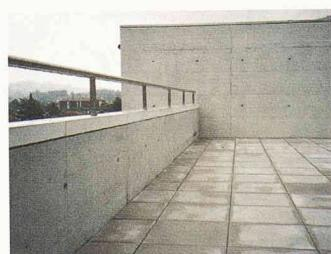
und kommt mit geringen Einbauhöhen aus. Das System kann im Hochbau überall dort angewendet werden, wo vertikale an horizontale Bauteile stoßen und an dieser Stelle ein dichter, technisch sauberer Abschluss gefragt ist. Ein mindestens 18 cm breites, 1,8 mm dickes, einseitig mit Vliesrand ausgerüstetes EPDM-Kautschuk-Band wird am Vertikalbauteil mit Epoxikleber und horizontal in der bituminösen Flächenabdichtung sandwichartig fixiert. Soba
