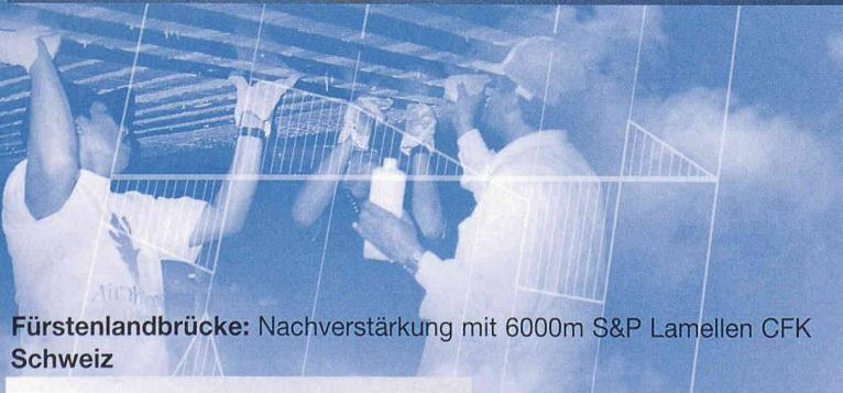
**Fürstenlandbrücke:** Nachverstärkung mit 6000m S&P Lamellen CFK Schweiz
