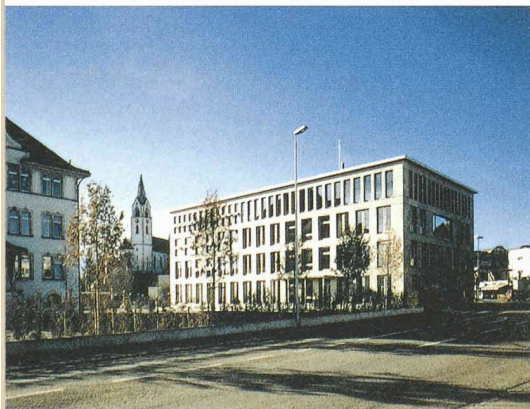
Der Schweizer Heimatschutz wird sich in diesem Jahr auf den Agglomerationsraum konzentrieren. Das Gemeindehaus von Jona SG (Architekten: Müller & Truniger, Zürich) ist ein Beispiel, wie ein selbstbewusster, städtischer Bau einer rasch wachsenden «Vorstadt» ein Gesicht geben kann (Bild: Heinrich Helfenstein)
