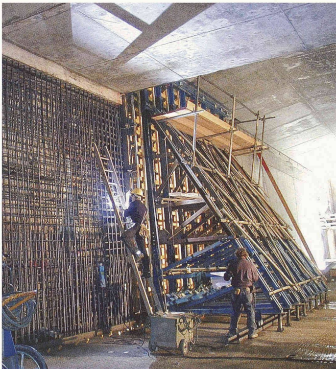
Selbstverdichtender Beton kommt auch beim Bau des Dock Midfield im Flughafen Zürich zur Anwendung: Bau der Schalung vor einer hoch armierten Wand
