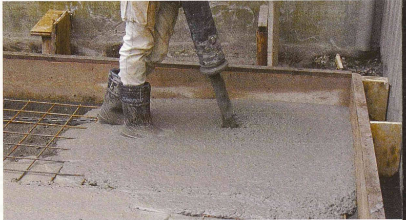
Einpumpen von selbstverdichtendem Beton in ein Fundament
