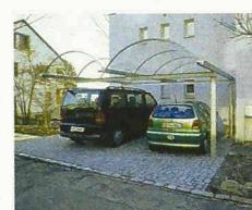
Car-Cupol ist langlebig, denn die Stahlkonstruktion ist feuerverzinkt und die Befestigungsteile sind rostfrei. Das Acrylgas ist lichtecht, witterungs- und alterungsbeständig, gebaut für eine lange Lebensdauer.
