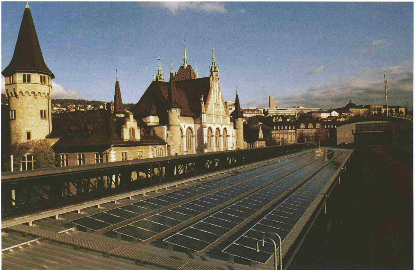
Solaranlage auf dem Hauptbahnhof Zürich, im Hintergrund das Landesmuseum
