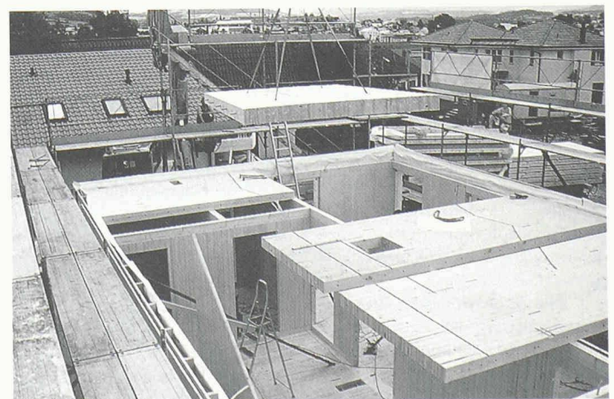
Verlegen von Bresta-Elementen
