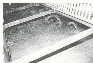
Mischen des Betons im Secatol
