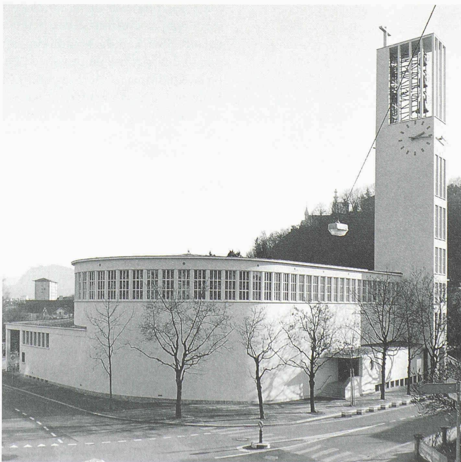
1 Nord- und Westfassade nach der Instandsetzung (Bild: J. Brun, Luzern)
