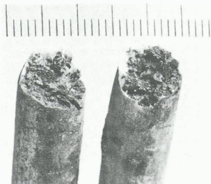
5 Gebrochene Bügel mit der für Spannungsrisskorrosion typischen spröden Bruchfläche
