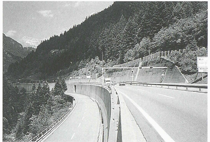
13 Stütz- und Wandmauern, Übersicht
