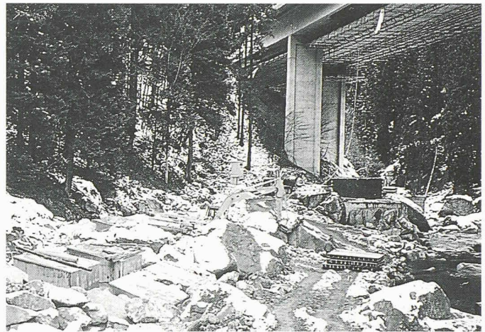
2 Betonprismen Pfeilerpaar Mitte (RO5)
