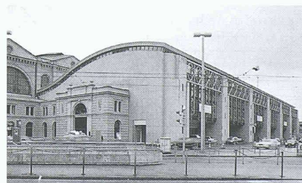
Der neue Nordtrakt des Zürcher Hauptbahnhofs
