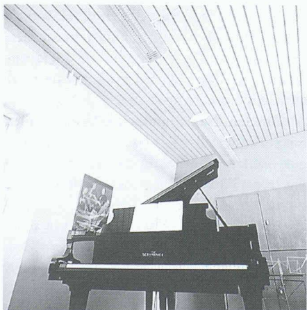
Aufbau der Schallabsorption zur Reduktion der Halligkeit. a) Schema mit 1: Decke, 2: Hohlraum mit Absorption, 3: Absorptionsmaterial, 4: Faserwolle, 5: Massivholzriemen und b) Foto (S. Schenker, Therwil)
