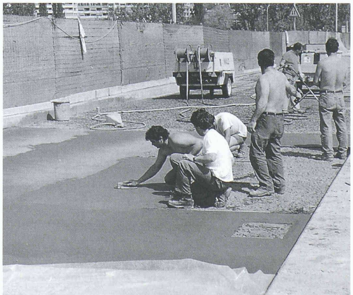
5 Reprofilieren der Betonoberfläche
