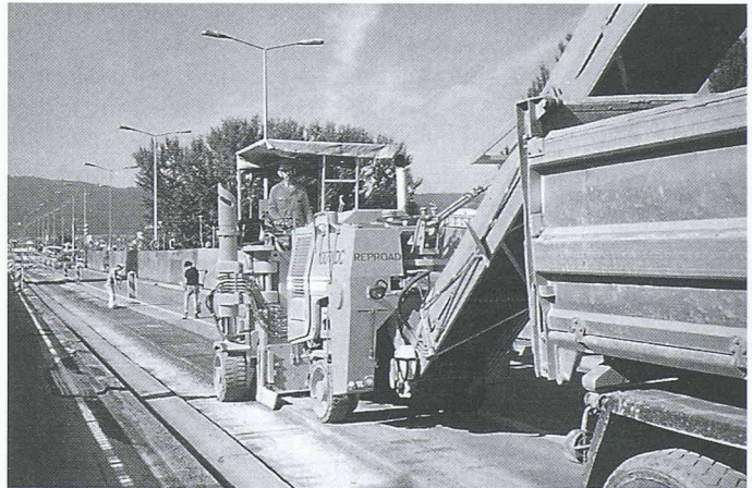
3 Abfräsen des alten Belags
