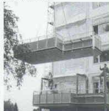
Mehr Wohnraum durch die vorge-setzten Balkone
