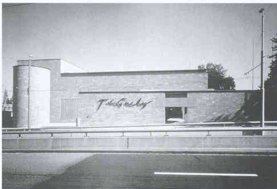
Nordfassade gegen die Grenzacherstrasse (Bild: Christian Baur, Basel)
