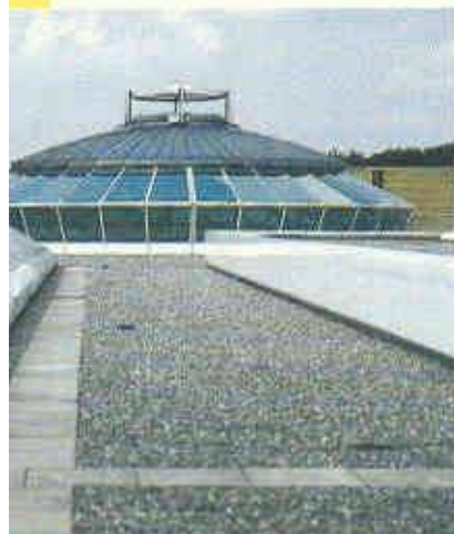
Umbau Einkaufszentrum Glatt. Mit Sarnafil T.
