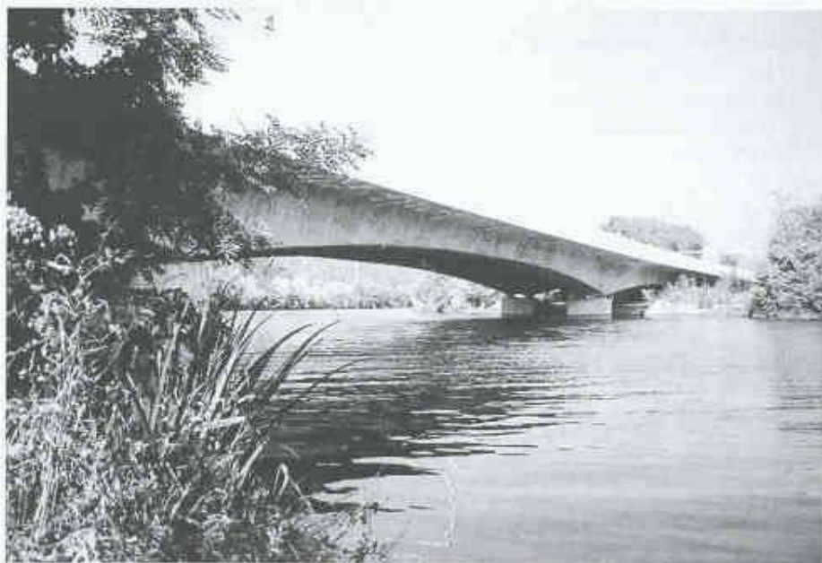
Die Aarebrücke quert, nur wenig über dem Gelände, mit schön geschwungenem Vouten-
