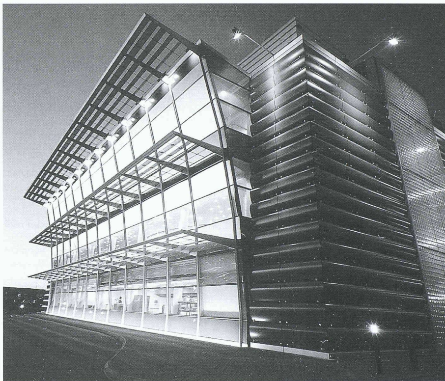
Das Compass Centre am Londoner Flughafen Heathrow ist wegen seiner eigenwilligen, konkav geformten Gestaltung für Radarstrahlen fast unsichtbar (Bild: LPS)
