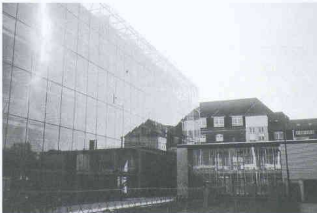
2 (unten) Geschäftshaus Hanauer Landstrasse, Frankfurt a. Main/D, Architekten: Schneider + Schumacher, Frankfurt a. Main/D
