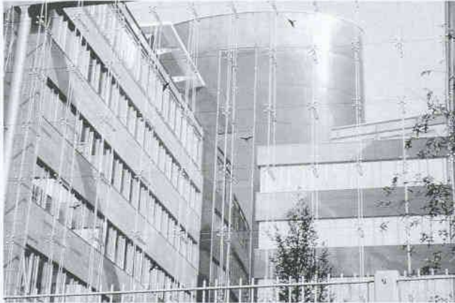
1 (oben) Lärmschutzwand Omegahaus, Offenbach/D, Architekt: Novotny, Frankfurt a. Main/D
