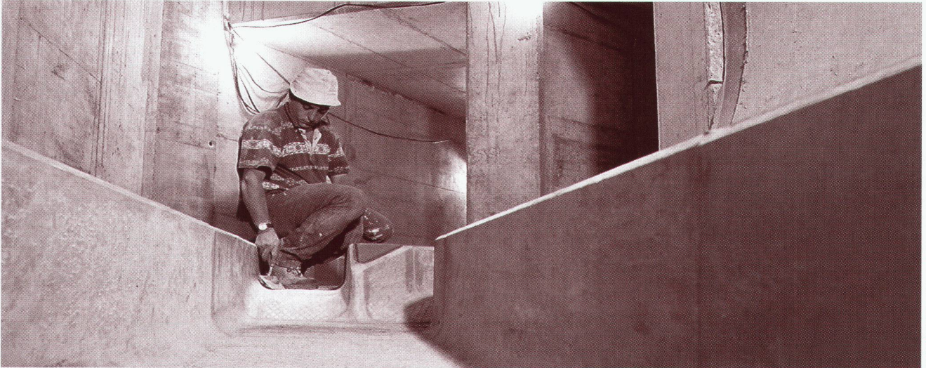
ACO-Sohlschalen, eingesetzt von der Preiswerk+Cie. AG und der Meier+Jäggi AG, Projekt: Kanalisation Zähringer-/Markgräferstrasse in Basel
