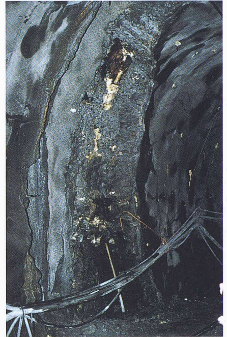
Bild 1. Altes und neues Tunnelgewölbe im Rufenen-Tunnel: Vorne ist die einschalig aufgetragene Spritzbetonschicht zu sehen, in der Bildmitte das ursprüngliche Tunnelgewölbe mit dem Natursteinmauerwerk und der Holzverkleidung. Die hellen Stellen sind Polyurethan-Verfüllungen und Verklebungen
