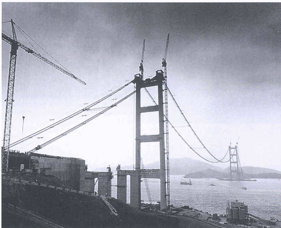
Hongkongs Tsing Ma Bridge wird ab 1997 den neuen, ebenfalls im Bau befindlichen Flughafen auf einer Insel mit dem Festland verbinden (Bild: LPS)
