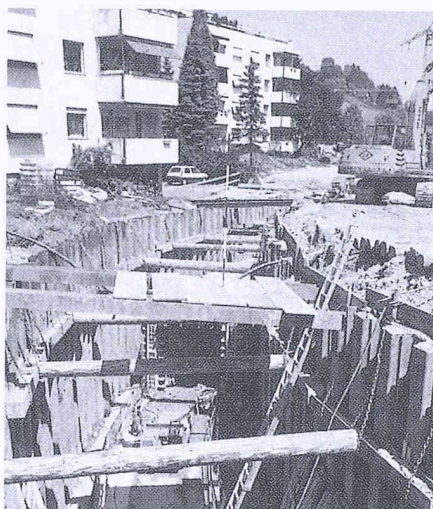
Bild 5. Ortbetonkanal, Aushubarbeiten Baugrube mit Spundwänden
