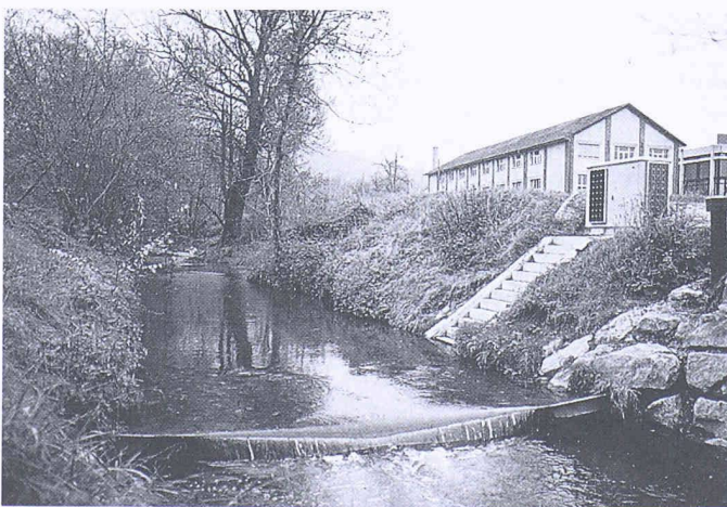
Bild 1. Die neue Messstation am Näfbach bei Neftenbach. Die Messschwelle mit der freien Überfallströmung wurde als Betonscheibe neben dem Bach erstellt und dann mit einem Kran millimetergenau versetzt. Der freie Kolk unter dem Wasserstrahl ist über 1,3 m tief und bildet einen willkommenen Lebensraum für die Fische. Die Stabilität der Schwelle und der Ufer ist durch den Blocksatz aus schweren Steinen gewährleistet. Das senkrechte Rohr neben den Steinen dient der Belüftung des Wasserstrahles. Über der Treppe mit dem schrägen Lattenpegel befindet sich der Gerätekasten mit den Sonnenkollektoren für die Mess- und Registriergeräte
