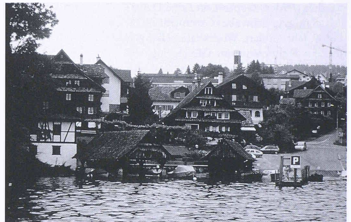
Schützenswerte Ortsbilder und Gebäudegruppen sind auszuweisen und zu sichern, wie etwa das Fischerdörfli in Meggen
