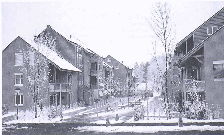
Bild 1. Die 47 Wohnungen der zweiten Bauetappe in Hünenberg (Teilansicht)
