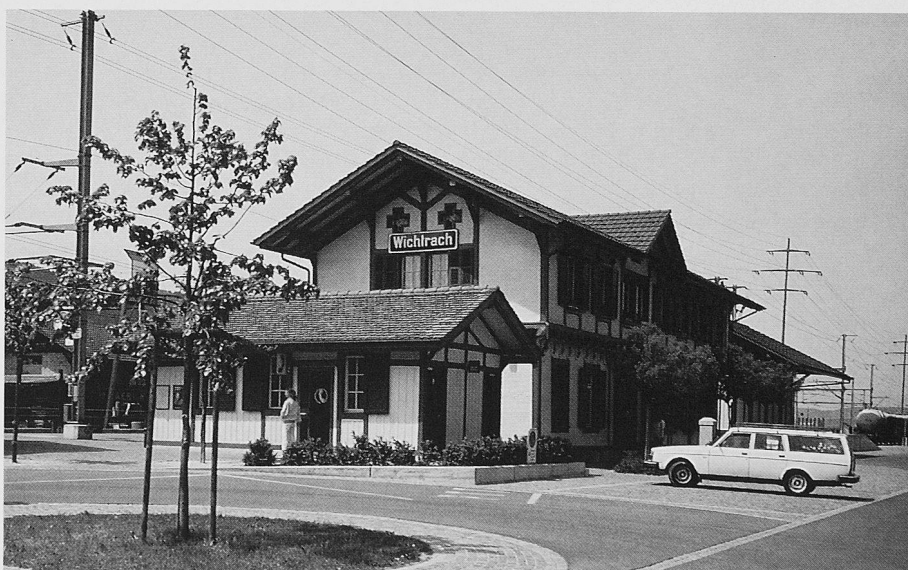
Bild 3. Die Bahn braucht auch neben der Schiene Energie: Bahnhof Wichtrach im Kanton Bern
