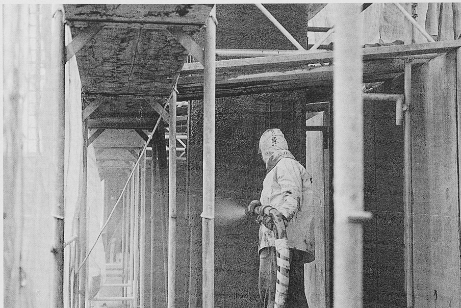
Bild 6. Applikation eines hochleistungsfähigen Spritzmörtels im Trockenspritzverfahren
